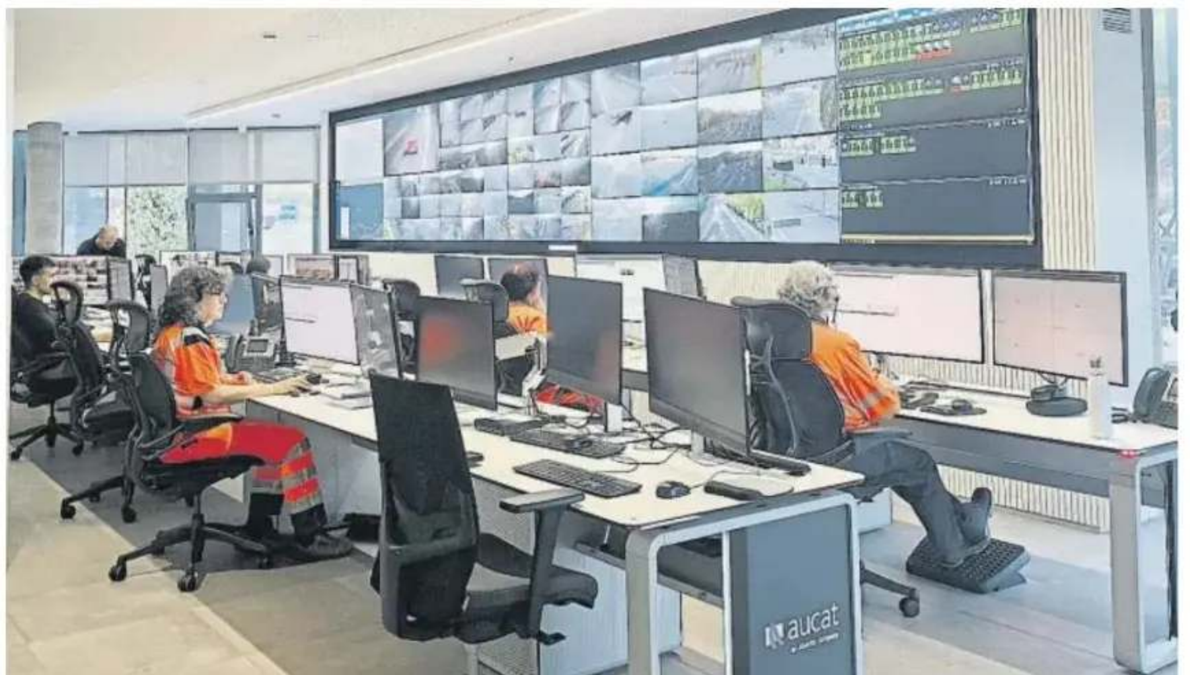
Centro de control de Abertis España para la gestión de autopistas
